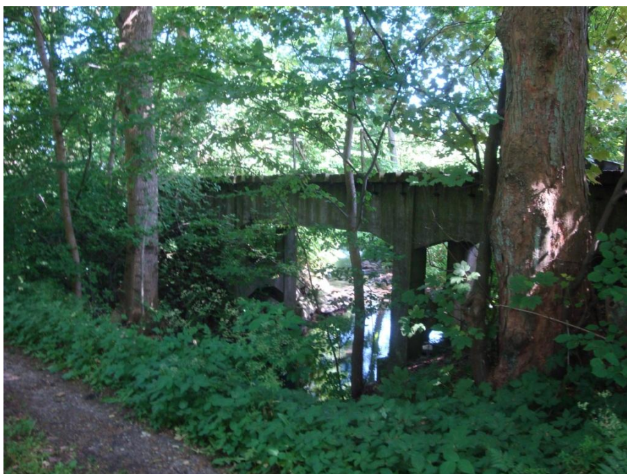
Jernbanebroen over Fladså lige øst for Mogenstrup Kro, juni 2014
